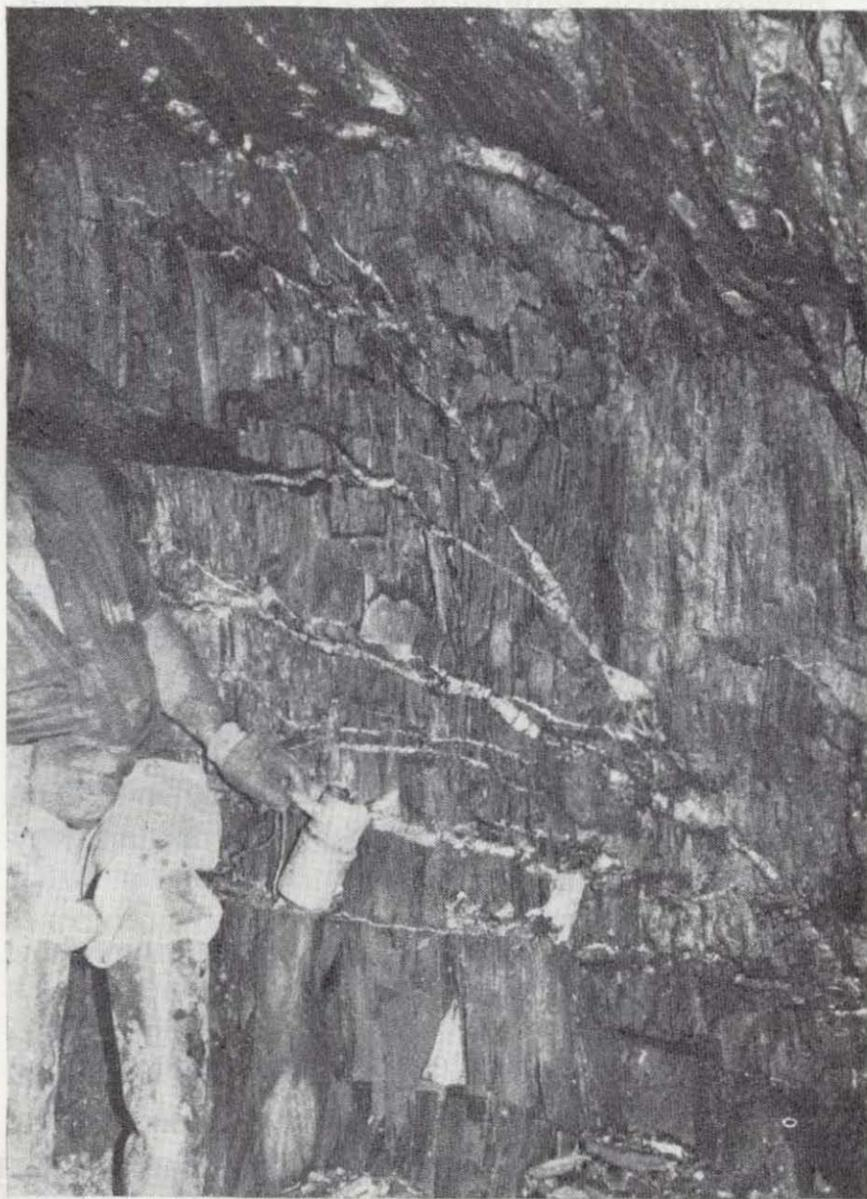
Figura 6.—Mina Sevillana: frente de explotación, con vetas  $Q_2$  mineralizadas, secantes a la esquistosidad  $S_1$ .
